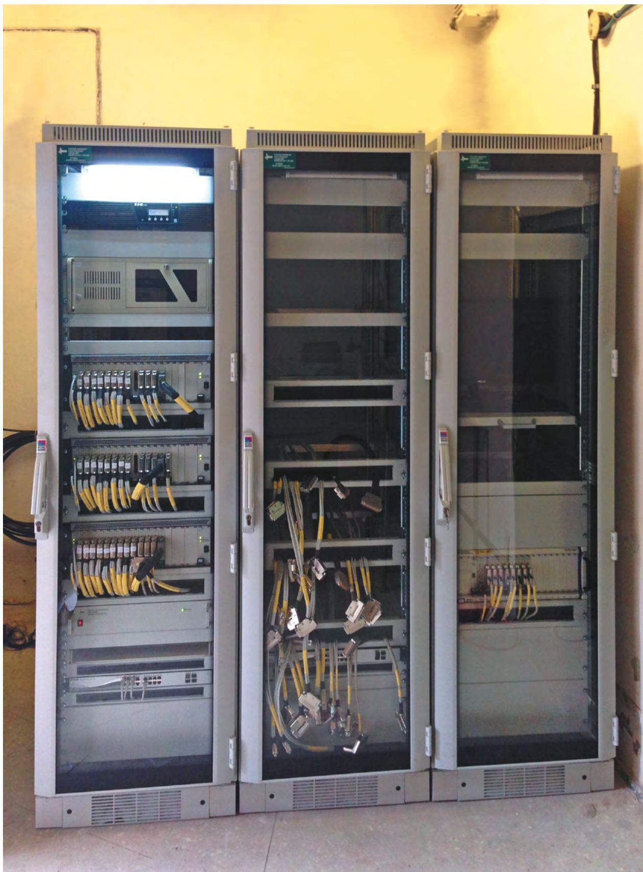
Приборные стойки с основными и резервными регистраторами в процессе монтажа системы
